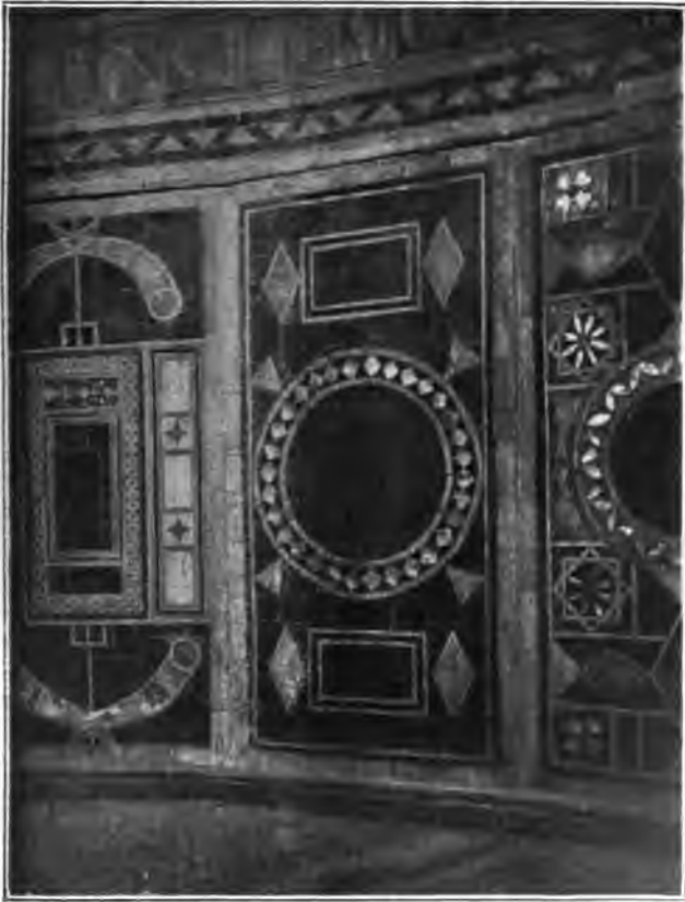
Fig. 88. — Parenzo. Revêtement de marbre, d'onyx et de nacre de l'abside. (Cliché Courtellemont).
